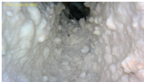
ポンプ設置前
