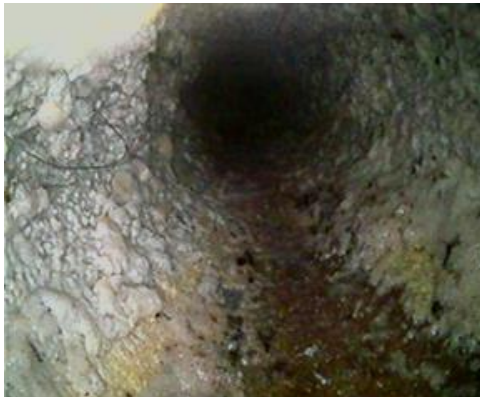
ポンプ設置前
